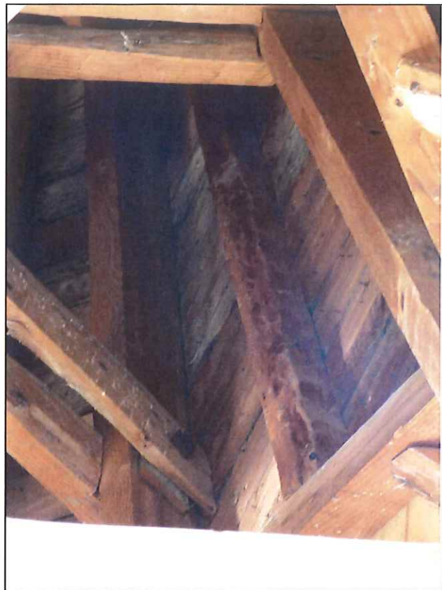
DETAIL DE LA CHARPENTE DU CLOCHER
