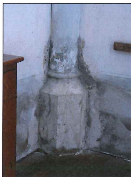
DETAIL D'UNE COLONNE
