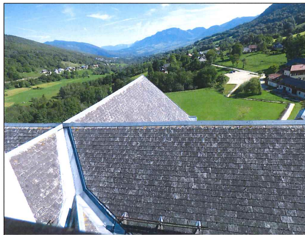
DETAIL DE LA COUVERTURE DE LA NEF
