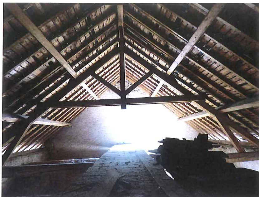
VUE DE LA CHARPENTE DE LA NEF
