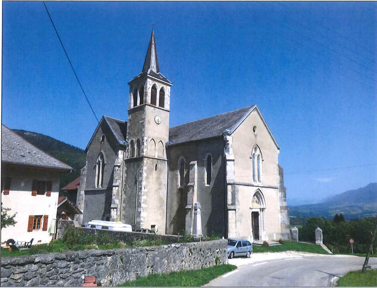
VUE DEPUIS SUD
