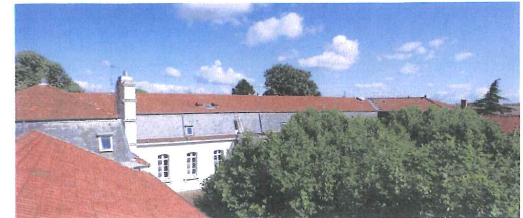
DP 7 - Photographie permettant de situer les travaux dans l'environnement proche
