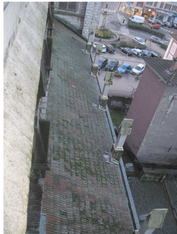
TUILES A EMBOITEMENT (TYPE ST VALLIER) DU BAS-COTE NORD
