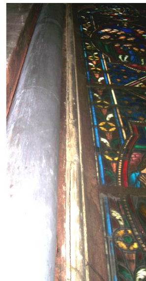
Fissures présentes sur toute la hauteur des jambages
