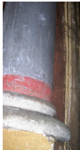
Fissures présentes sur toute la hauteur des jambages
