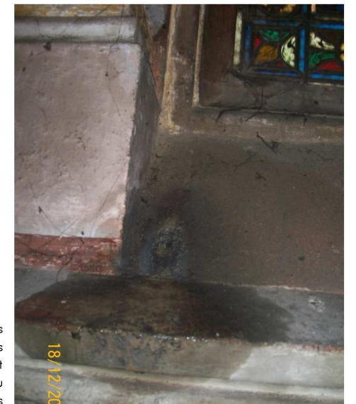
Fissures traversantes : jours visibles au travers des maçonneries
